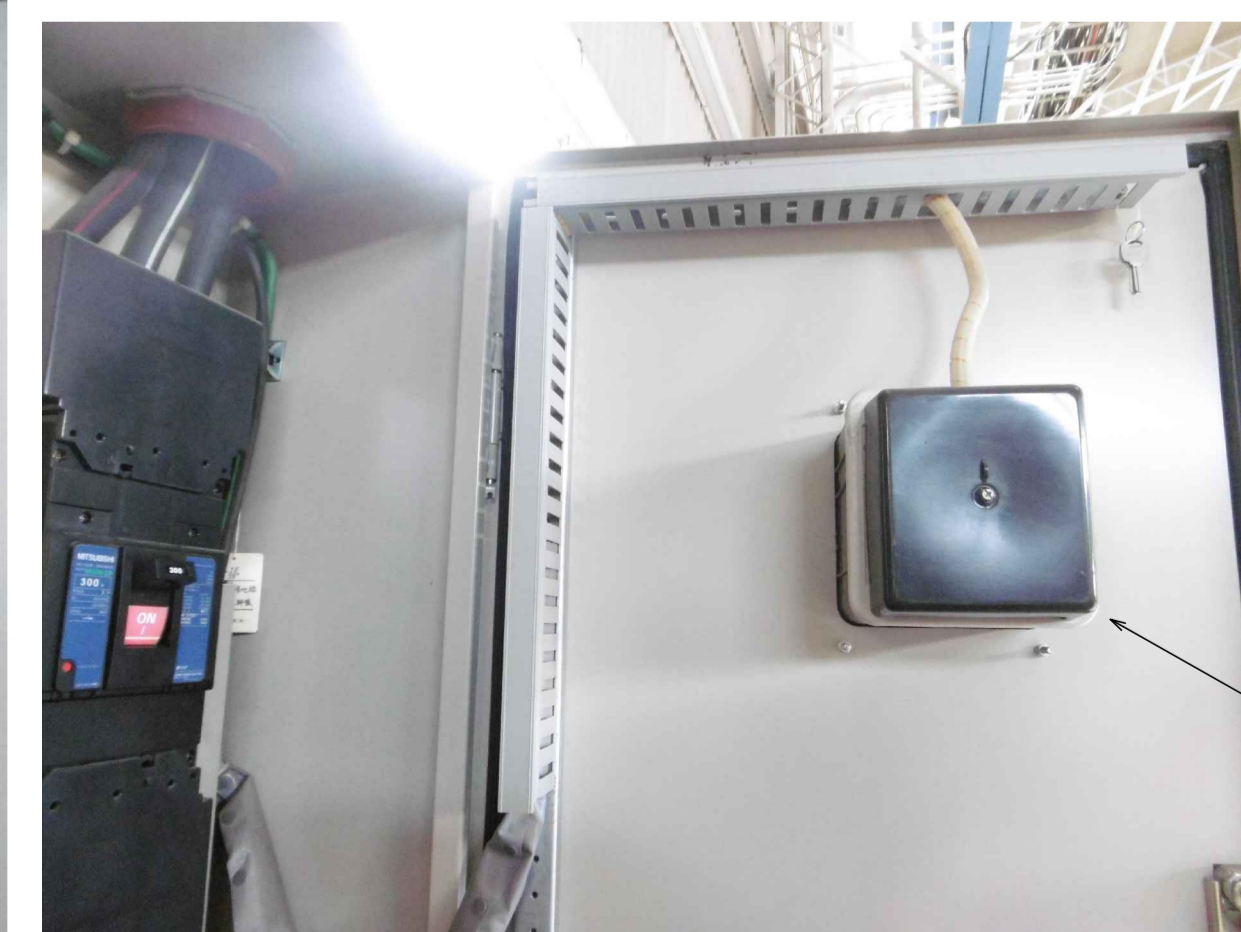
扉面の既設電力量計を撤去し、網入りガラスを設置する
