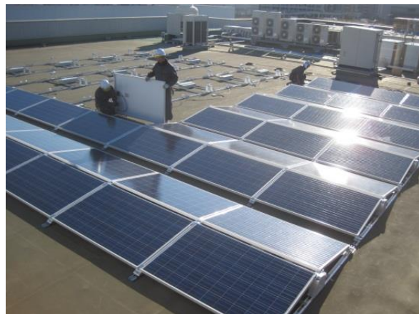
▲ 太陽光パネル設置の様子
