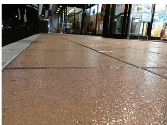
ラージエリア施工
