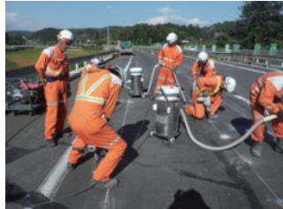
高速道床版補修
