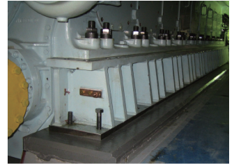
大型機械設置
