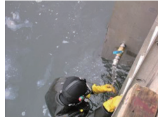
水中コンクリート補修
