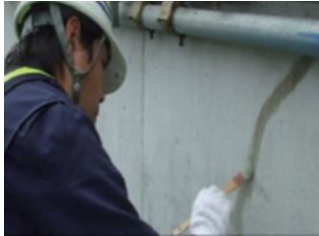
コンクリートひび割れ補修
