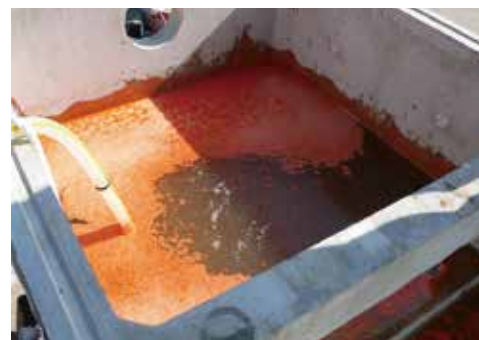
油水分離風景
