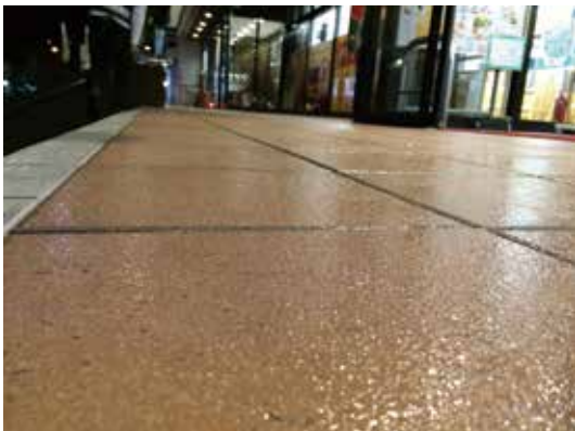
ラージエリア施工
