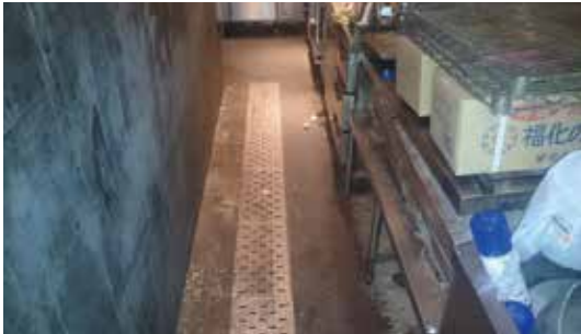
厨房床施工前
