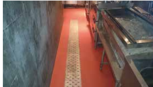
厨房床施工後
