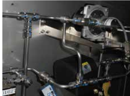
小口径パイプの曲げ配管
