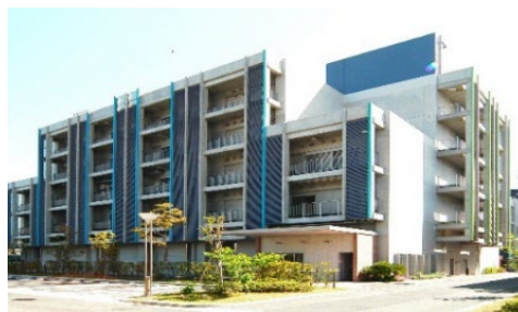
横浜新技術創造館外観
