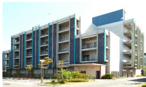
横浜新技術創造館外観
