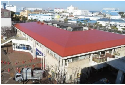
サービス棟屋根塗装
