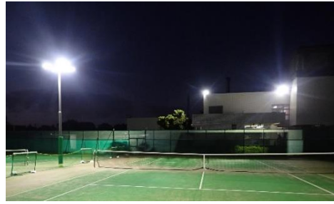
テニスコート照明設置
