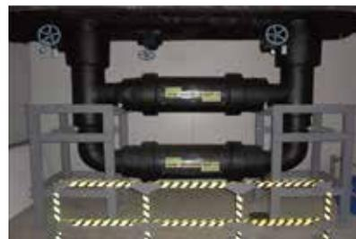
給水管マグネタイト工法™ (赤錆の黒錆化で劣化パイプの薄い肉厚を元の厚さに復元)
