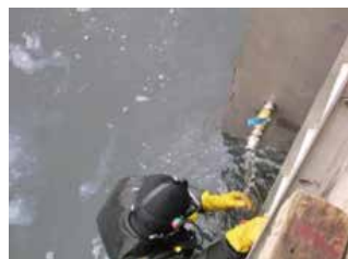
水中コンクリート補修
