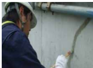
コンクリートひび割れ補修
