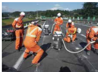
高速道床版補修
