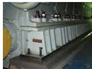
大型機械据付
