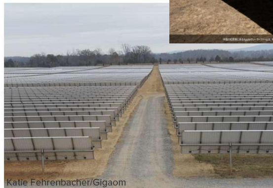
Katie Fehrenbacher/Gigaom メイデン、ノースカロライナ州のデータセンターの隣にあるアップル社の太陽農場
