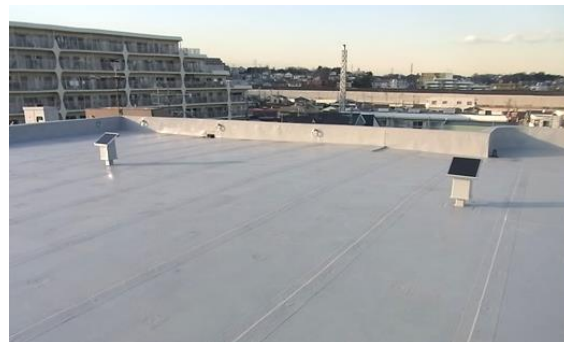
▲エアークントロール工法の屋上
